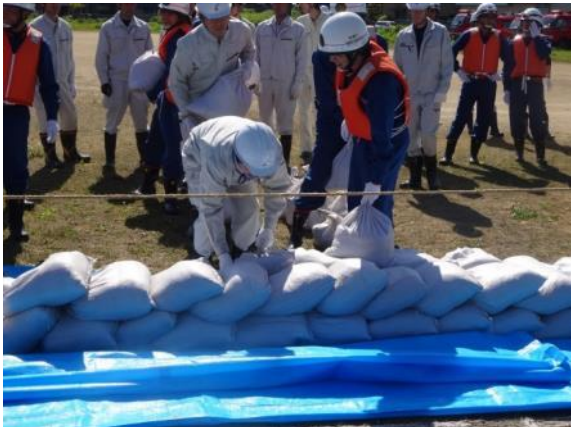
改良積み土のう工法
